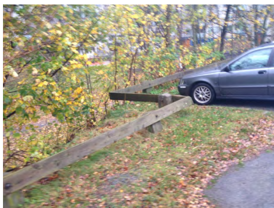
Foto 3 och 4. Gångväg, parkeringsyta, staket och kantsten lutar åt norr vilket tyder på att sättningar eller att vissa markrörelser pågår
