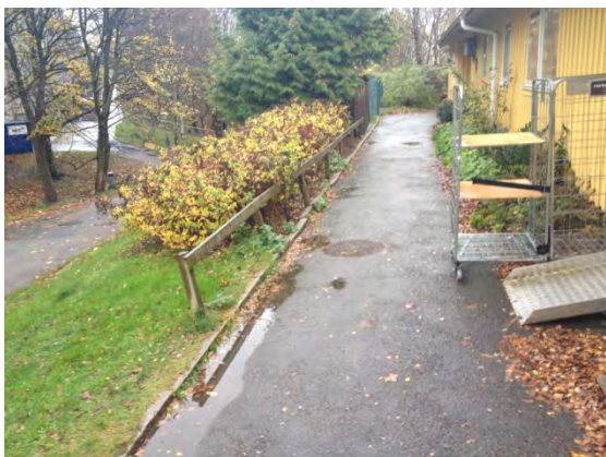
Foto 3 och 4. Gångväg, parkeringsyta, staket och kantsten lutar åt norr vilket tyder på att sättningar eller att vissa markrörelser pågår
